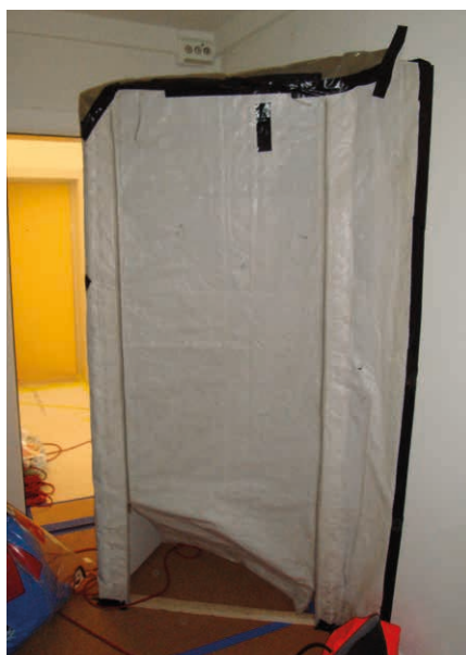
Schmutzschleuse zum Umbaubereich
