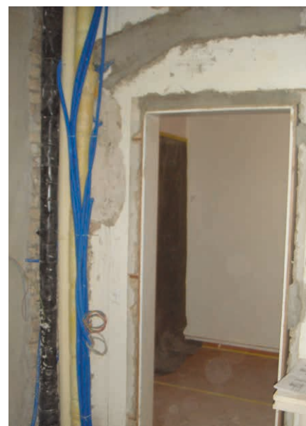
Neue Wasserversorgung und -entsorgung
