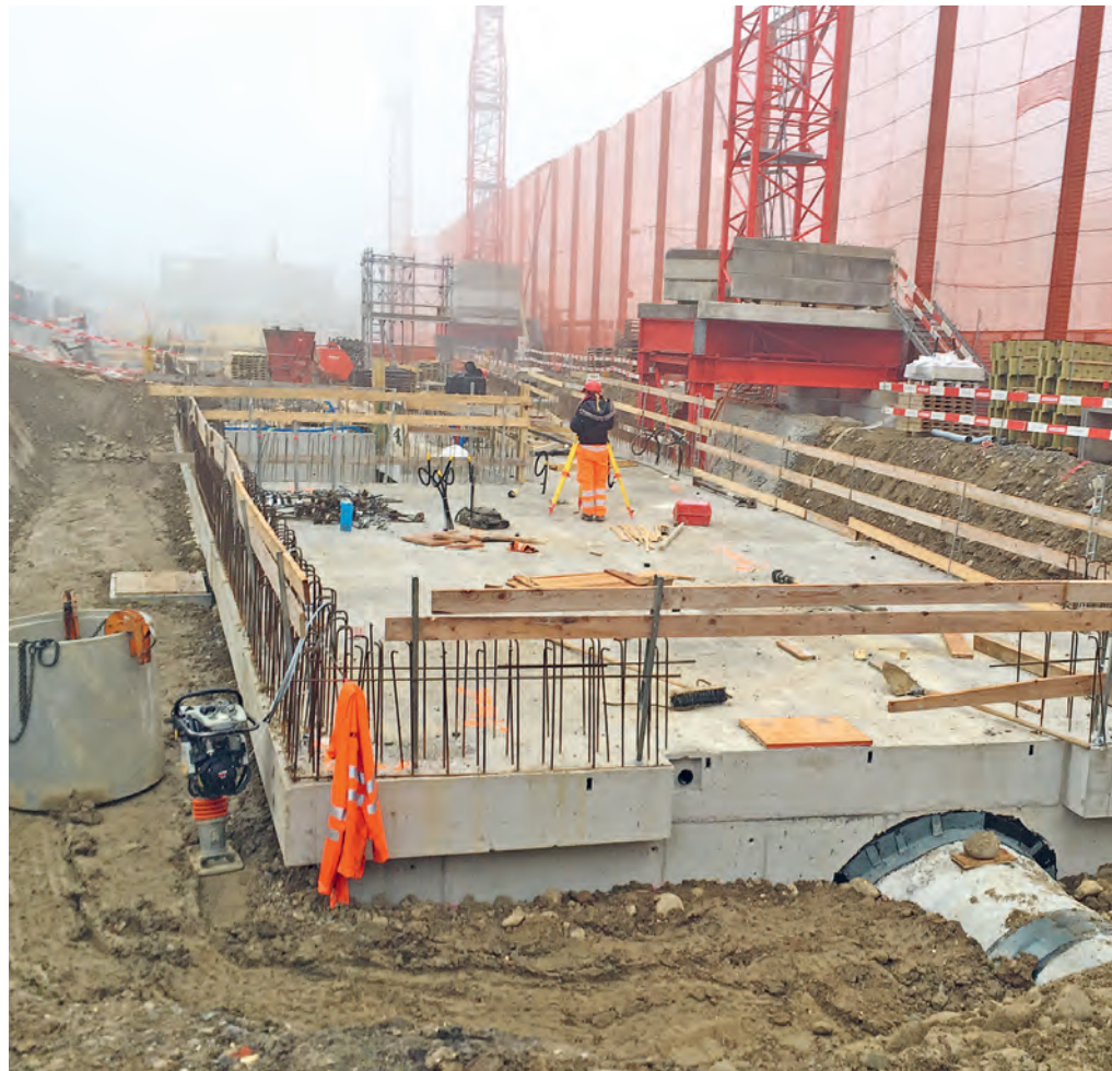
Rechts: Südspitze Baufeld A1 mit betonierter UG-Decke
