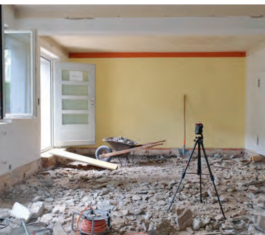
Die Geschäftsstelle in der Siedlung Hofgarten bleibt bestehen und wird renoviert
